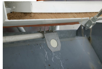
Einbau unter Siloausläufen
