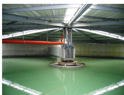
Einbau direkt in Absetzbecken
