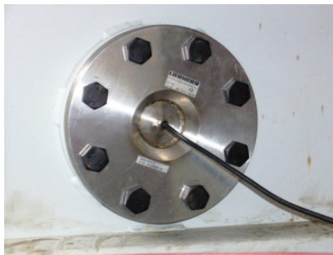
Sensoreinbau in Außenwand des Absetzbecken
