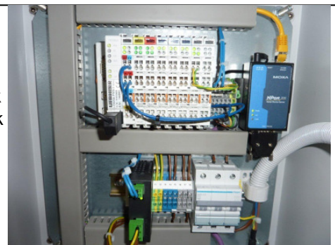
Einbau Elektronik in Schaltschrank
