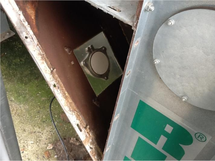
Der Feuchtegehalt im Medium wird in-situ gemessen, das heißt in Echtzeit. Der im Sensor eingebaute Mikroprozessor sichert auch die komplette Reproduzierbarkeit, das heißt bei nachträglichen Erweiterungen der Anlage mit Sensoren oder bei einem Sensortausch ist keine Neukalibrierung notwendig. Der Sensor gleicht selbsttätig die Schwankungen der Medientemperatur aus, die einen Messwert negativ
