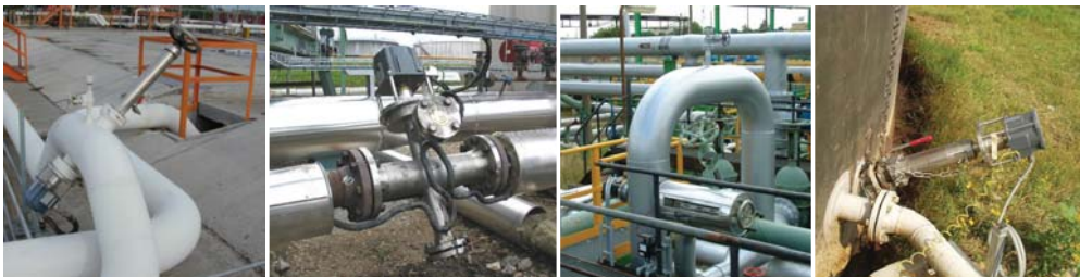
Pipelineeinbau mit Wechselarmatur
